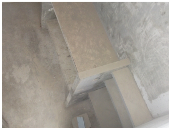
d) Vista por cima das celas. Cama e bancada de estudo em alvenaria.
