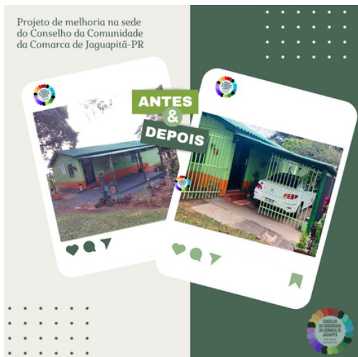
Pintura da grade de proteção da área externa.
